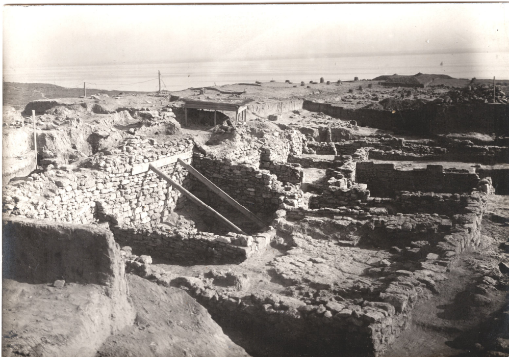
Рис. 12. Загальний вигляд ділянки I (II), 1937 р.
