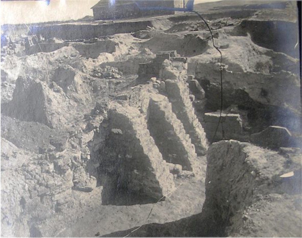
Рис. 11. Загальний вигляд кам'яних контрфорсів.
